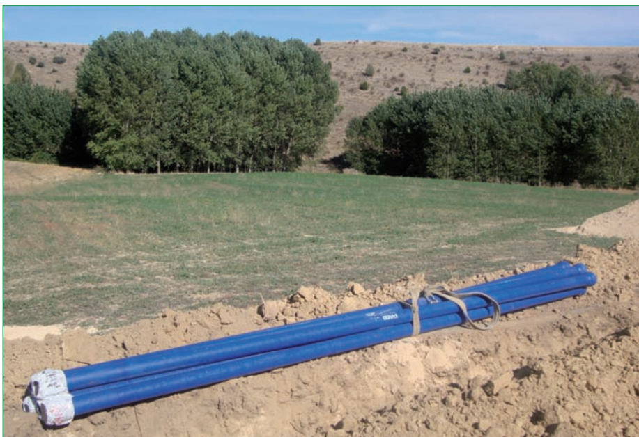
Abastecimiento Mancomunidad Villa y Tierra de Pedraza (Segovia 2010-2011) 22,4 Km Tubería Natural; 4,7 Km de Tubería Stándard, Stándard PUR y Stándard Ve; 25 Km Tubería Blutop
