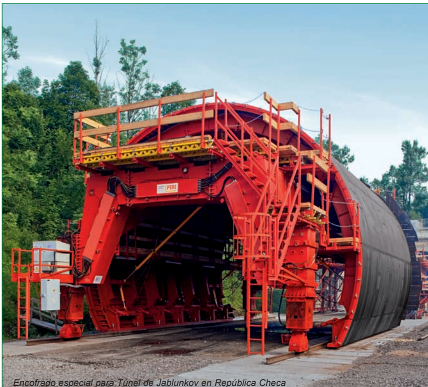
Encofrado especial para Túnel de Jablunkov en República Checa
