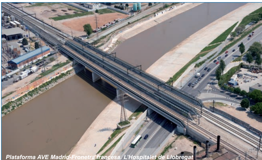
Plataforma AVE Madrid-Frontera francesa. L'Hospitalet de Llobregat
