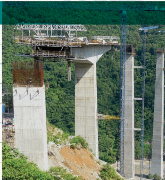
Viaducto San Marcos (México)
