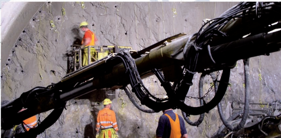
Túnel de Tiergarten (Alemania)
