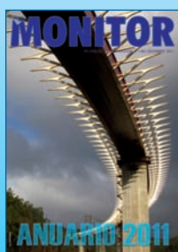
COPROSA: Viaducto El Regueiron en Autovía A-63
